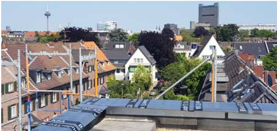
Das Dach des neuen Fliesteden- und Benderhauses ist inzwischen fertig. Von hier oben sind sogar die Domspitzen erkennbar.
