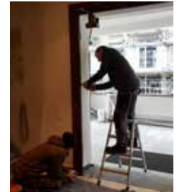
Die alte Eingangstür wird ausgebaut.
