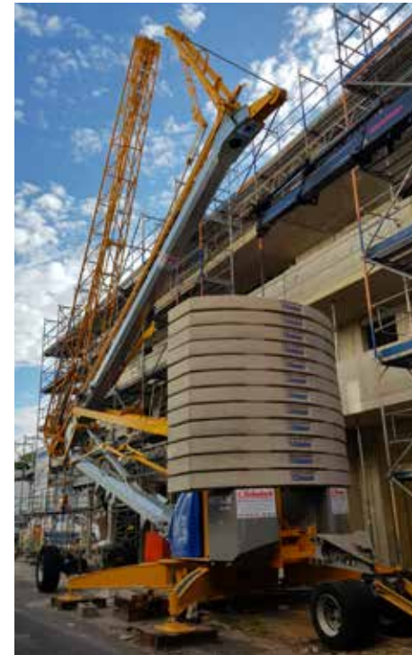
Der Kran in der Peter-von-Fliesteden-Str. 2 ist zur Fertigstellung des neuen Gemeindezentrums nicht mehr vonnöten. Er wurde Anfang Juli 2020 abgebaut.
