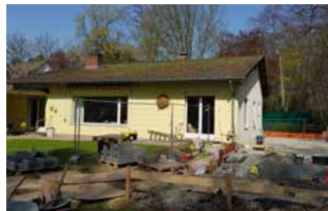
Bodenplatte für den Anbau ist fast fertig.
