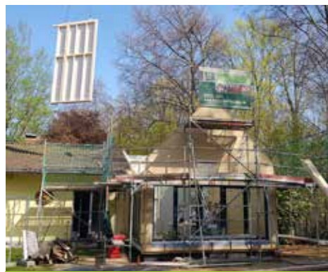
Innerhalb eines Tages steht der Anbau.
